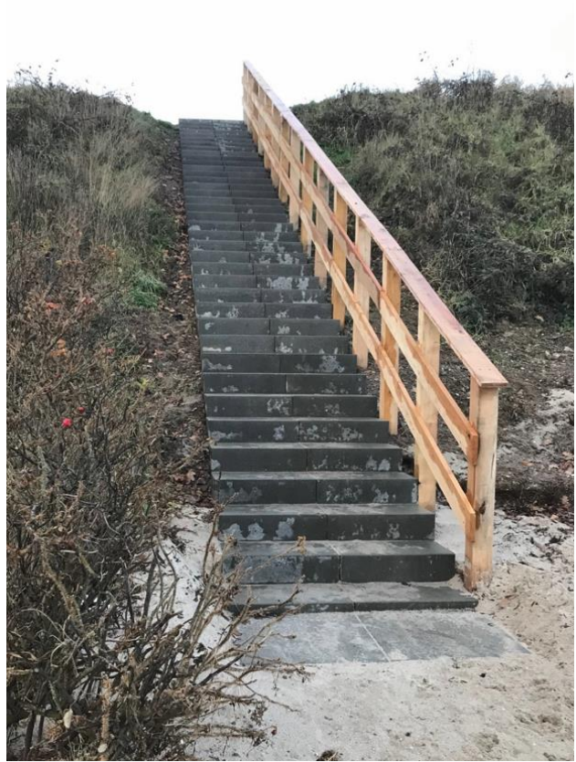
En ny betontrappe
